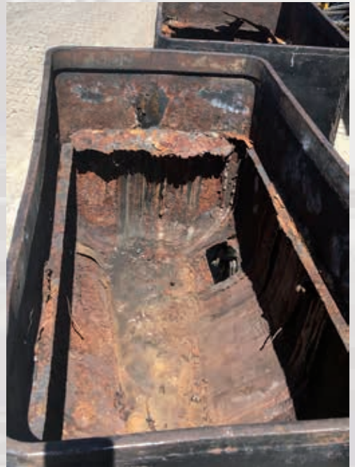
So sieht ein leerer Hunt von oben aus. Der Zwischenboden, wo die Kohle drappiert war, ist entnommen worden – jetzt wird saniert (Bilder: Ferdi Seidelt/1, Abdullah Altun/2).
