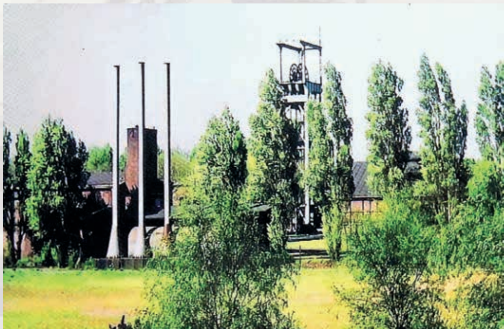
So sah Walter Stärk von seinem Küchenfenster aus (Karl-Matull-Platz 8) das Bergwerk. Das Kraftwerk versorgte auch die umliegenden Häuser (Bilder: Bergbausammlung, Walter Stärk).
