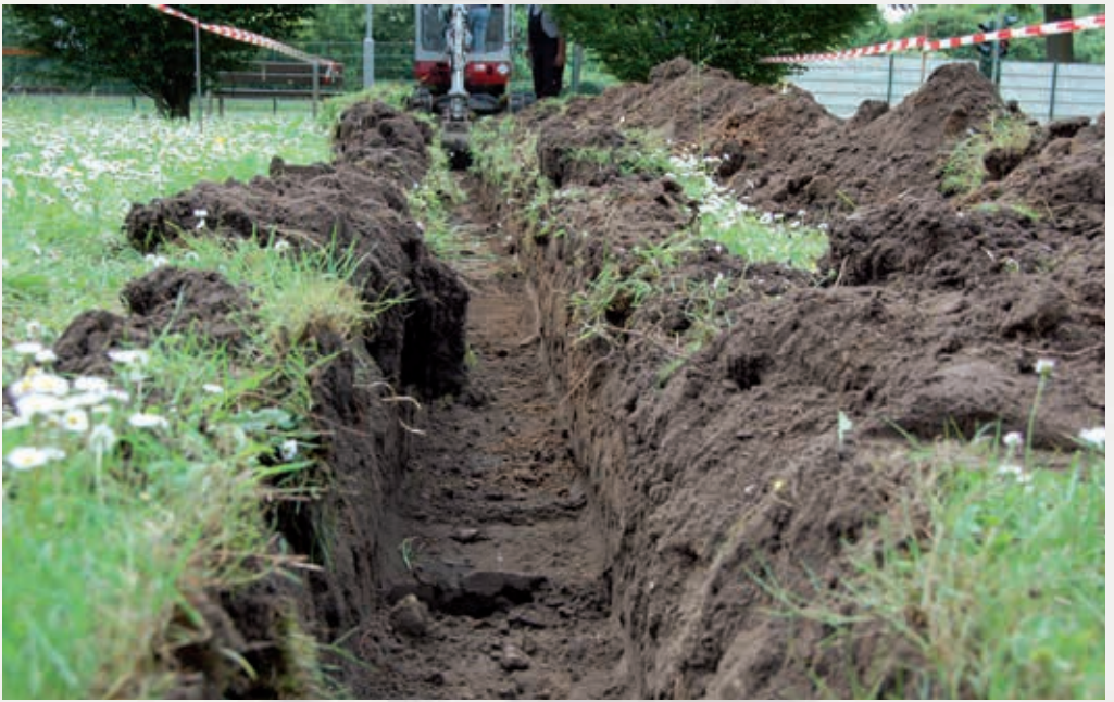
Wo ein Bagger im Einsatz ist wächst auch in Rumeln-Kaldenhausen zuerst einmal kein Gras mehr.
