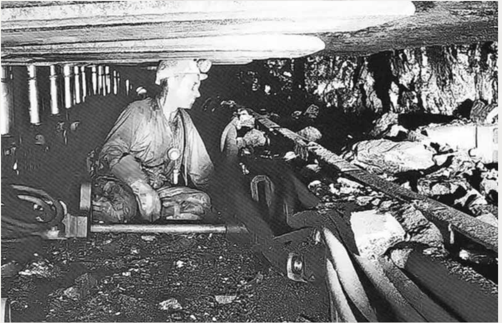
1971: Der erste Rahmenausbau mit dem Reißshakenhobel und Panzerförderer im Flöz Kreftenscheer 1, Maloche pur.
