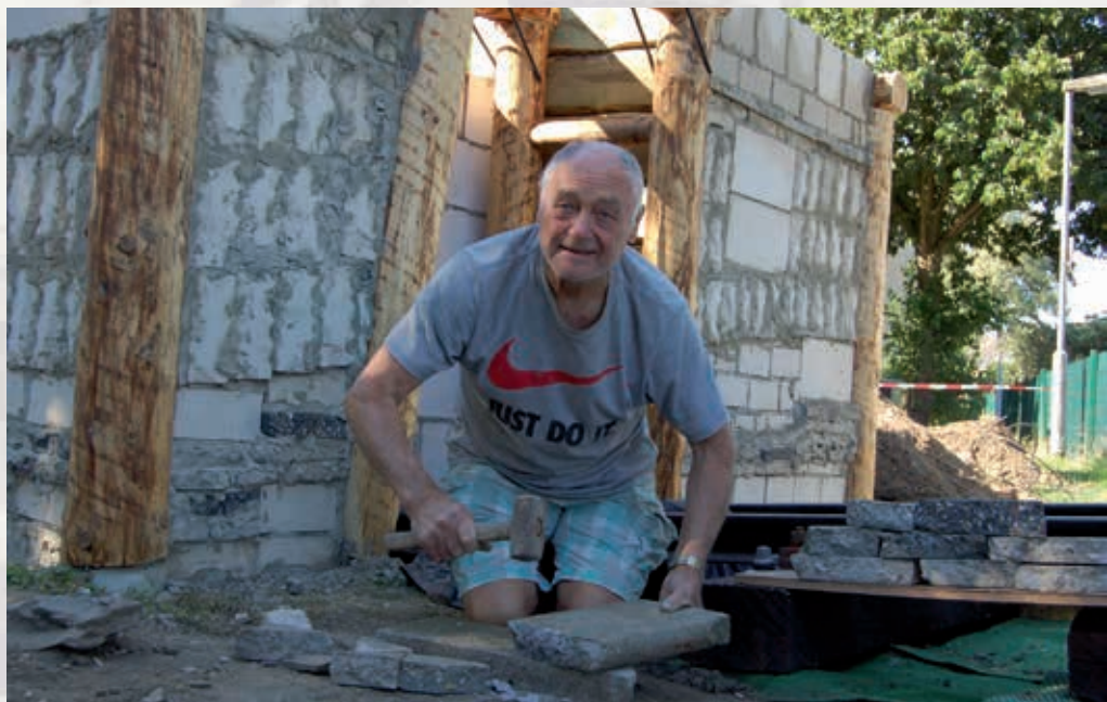
Baustelle Rumeln. Die geologischen Schichten entstehen! Kunsthandwerker Heinz Billen arbeitet insbesondere mit Steinbruch. Der eignet sich vorzüglich zur Darstellung einer Schichtung (Bilder: Ferdi Seidelt).
