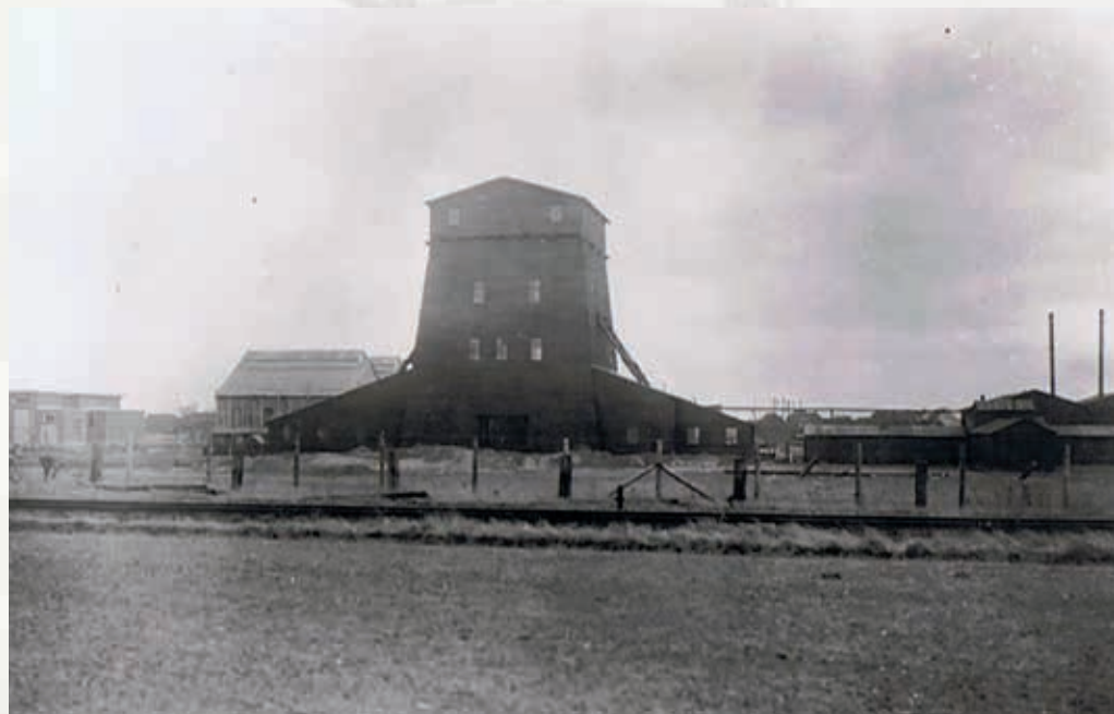
Der Abteufturm für den Schacht Rumeln wurde mit Holz verkleidet, um Mensch und Maschine vor der Witterung zu schützen. Das war 1937, nach gut einem Jahr waren die Arbeiten beendet.
