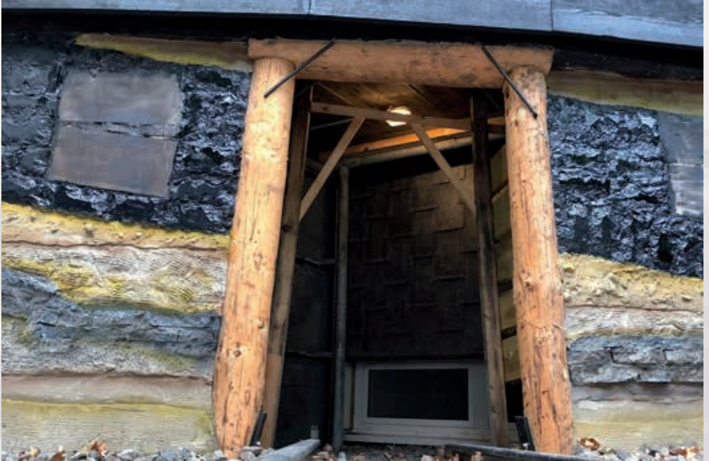
Schon sehr weit fertig ist in diesem Moment der „Rheinhauser Stollen“ mit Deutschem Türstock, Flöz Mausegatt und verschiedenen geologischen Lagen (Bilder: Ferdi Seidelt, Heinz Billen).
